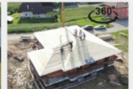
Überwachung einer Baustelle mit automatischer Rundumsicht
