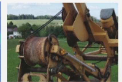
Inspektion eines Baukrans aus sicherer Distanz mittels Teleobjektiv
